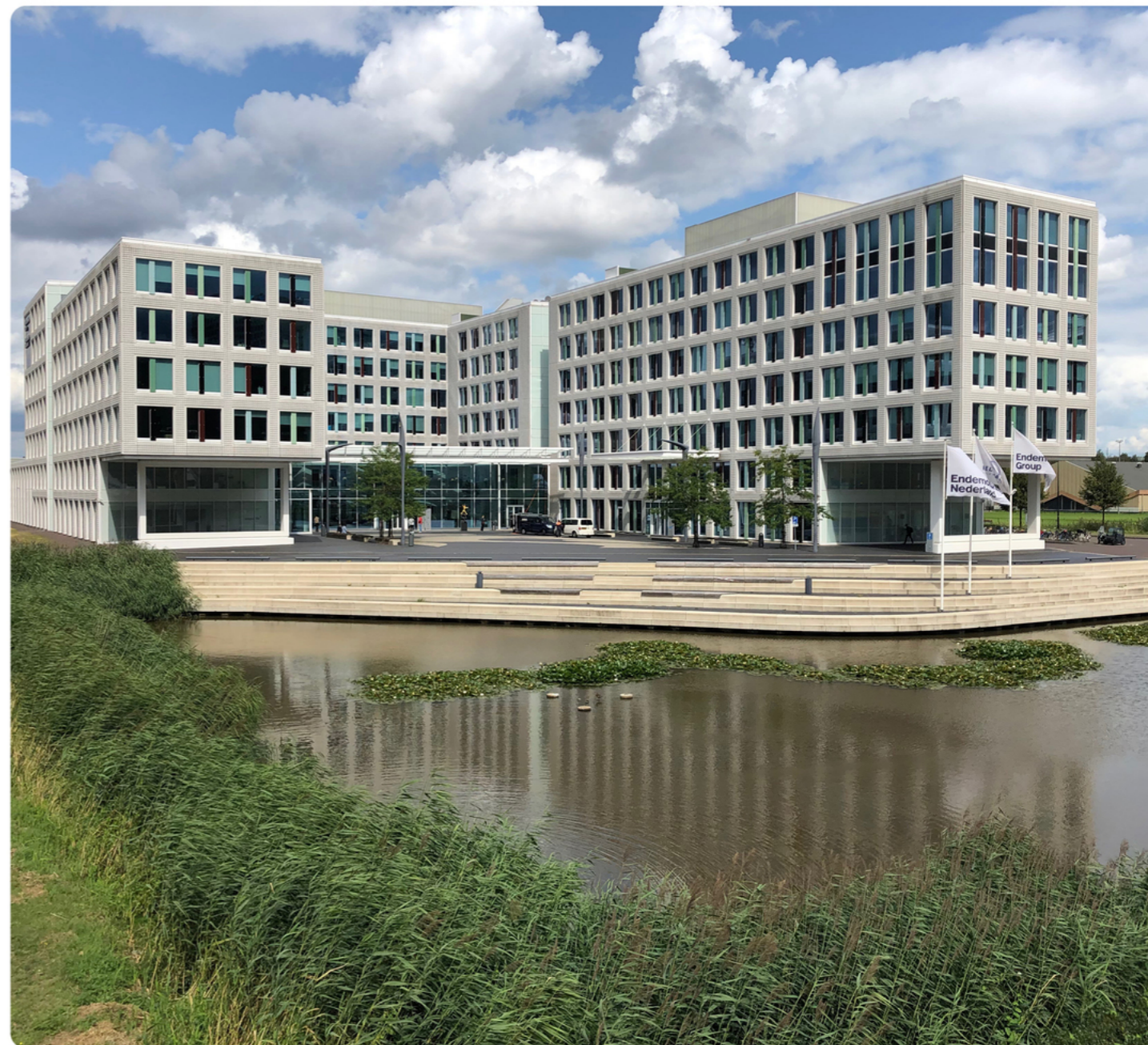
Qube Offices, Amsterdam Duivendrecht
